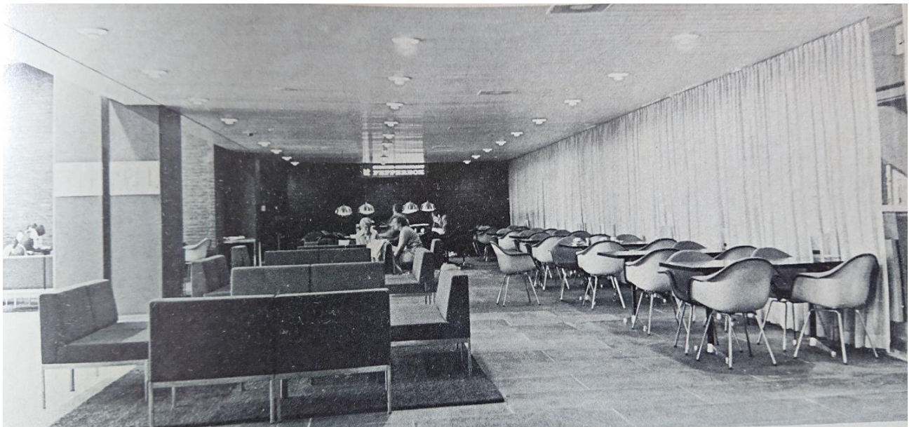
'lounge' achter de centrale hal
