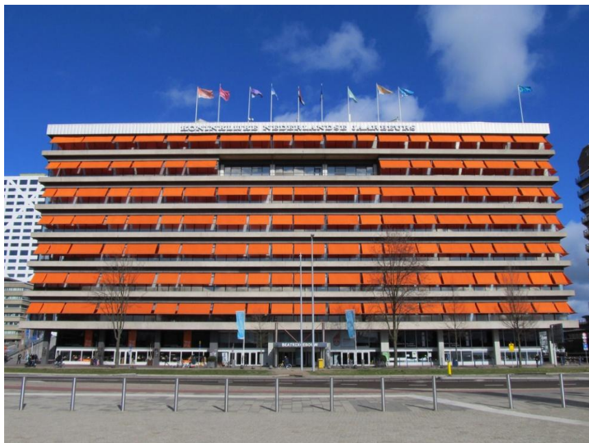
Figuur 5-11: Beatrixgebouw met uitgeklapte zonneschermen (Bouwput Utrecht)
