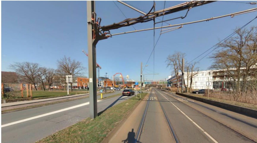
Figuur 5-3: Zicht tramtracé op doorsnijding van de Hoofddijk met de Stellenboschlaan
