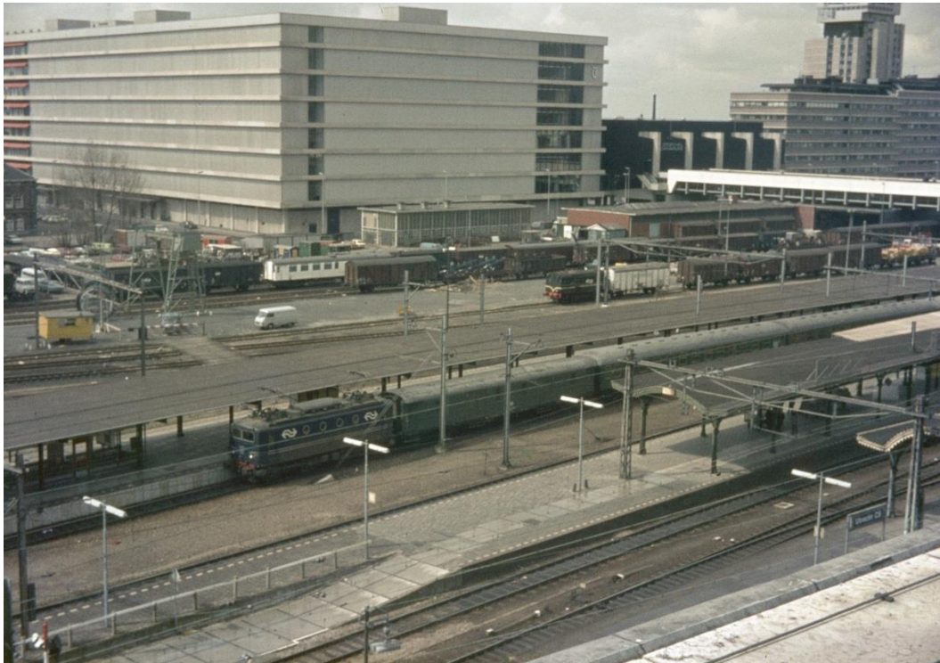
Aan de spoorzijde werd op twee plaatsen een deel van de gesloten gevel geopend.
