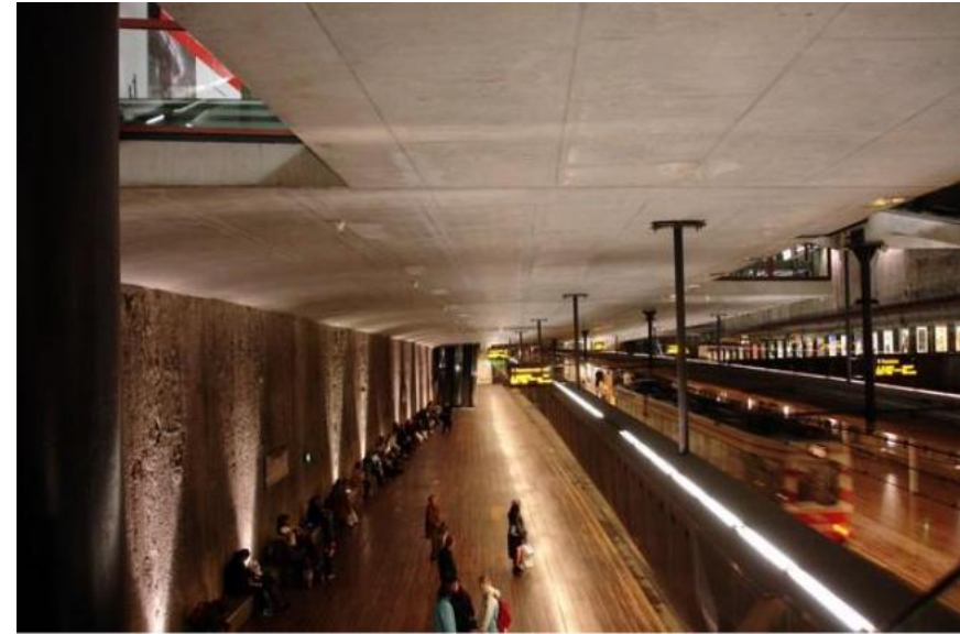
Figuur 40: Ondergrondse tramhalte Grote Markt in Den Haag (COB)
