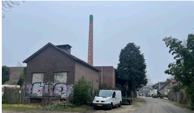
Trafo gebouw van de Nettenfabriek
