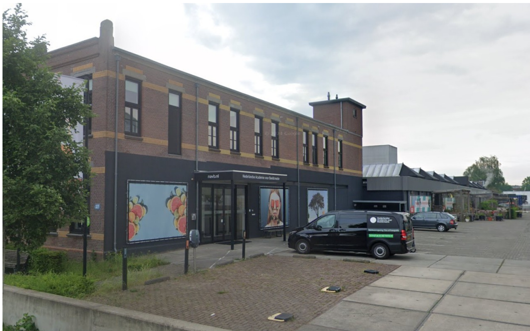
Figuur 27: Kantoor uit 1950 met daarachter de fabriekshal uit 1900 van de Nettenfabriek (Google Street View, mei 2024).
