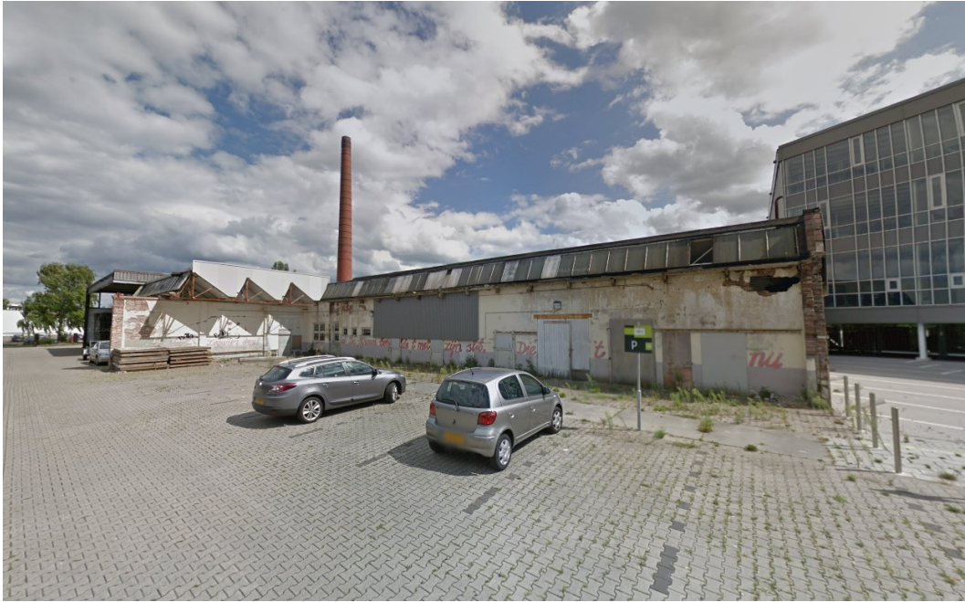
Figuur 24: Het zuidelijke gebouw op het terrein van de Nettenfabriek (Google Street View, augustus 2017).
