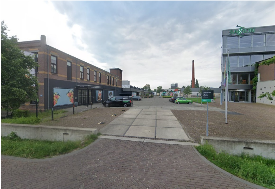
Figuur 26: Westelijke ingang van het terrein van de Nettenfabriek (Google Street View, mei 2024).
