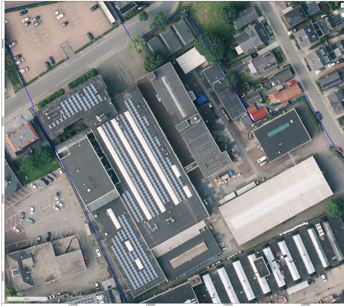
Figuur 11: Luchtfoto van het Royal Talens fabriekscomplex.
