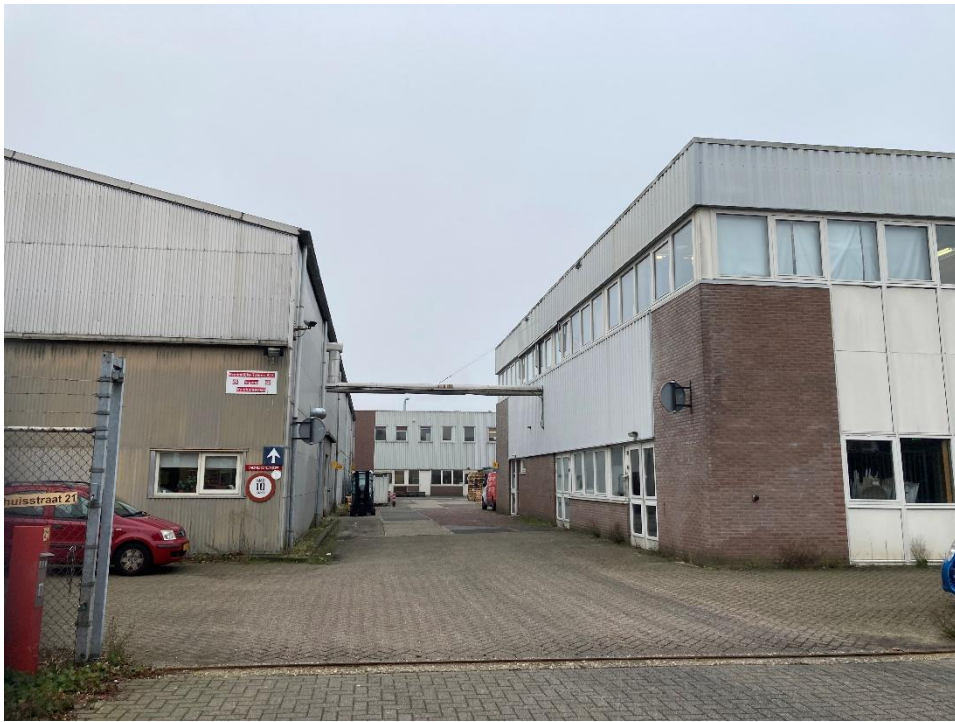
Ingang Talensterrein vanaf de Veldhuisstraat met links gebouw 11 en rechts gebouw 10.
