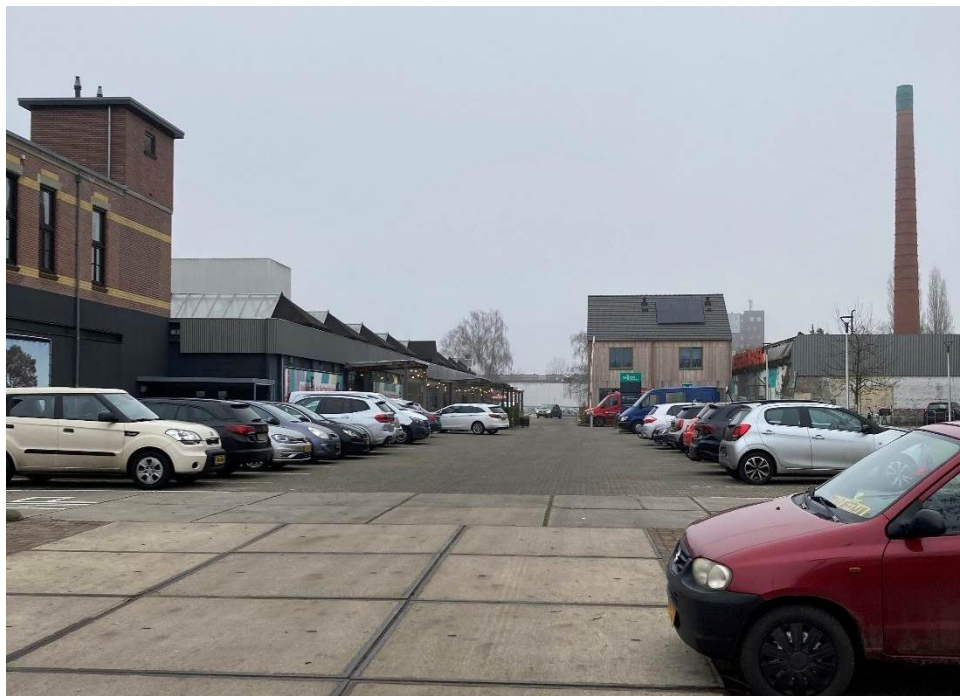
Terrein voormalige Nettenfabriek vanaf het busstation/spoorstraat met van links naar rechts: fotovakschool (buiten projectgebied) gebouw 13, 17 en 18, op de achtergrond de schoorsteen van het ketelhuis (gebouw 14).
