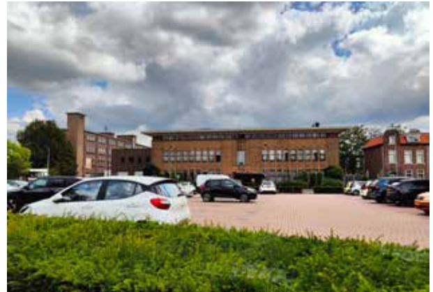
Talens Hoofdgebouw en Magazijngebouw vanaf Molenstraat-centrum
