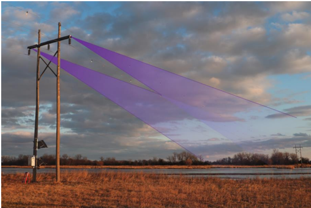
Figuur 7.1 Visualisatie van het Avian Collision Avoidance System (ACAS) in werking. Vanaf een bestaande mast (in dit geval van een distributielijn) wordt met UV-A lampen over de draden geschoven. In twee gepubliceerde onderzoeken was het bereik van de gebruikte lampen ongeveer 260 m afstand (bron: Baasch et al. 2022).
