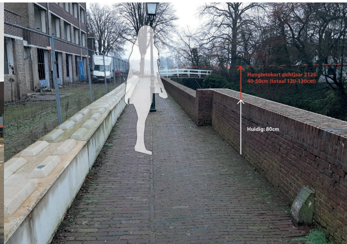
Hoogtetekort Prinsenstal (alléén in KA1)
