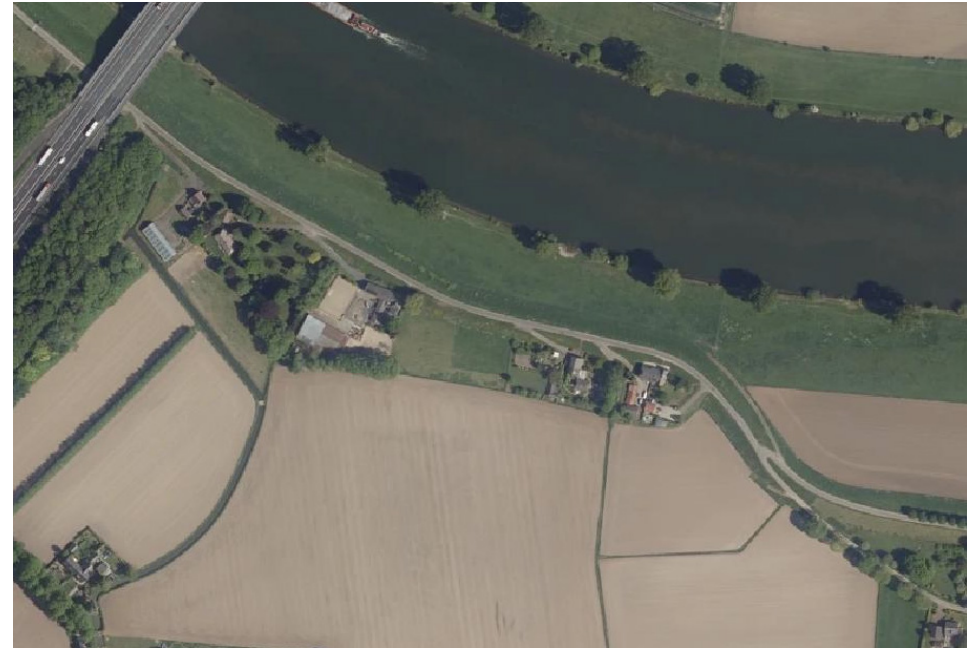
Figuur 3.42 - Luchtfoto dijkvak 37
