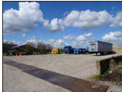
Figuur 10. Verhard terrein op noordwestelijk gedeelte van de onderzoekslocatie.
