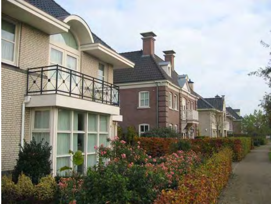
^ recente nieuwbouw Gemeente Gemert-Bakel
