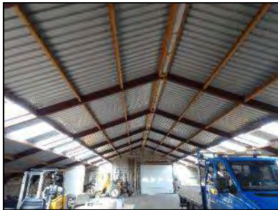
Figuur 9. Binnenzijde voormalige koeienstal.
