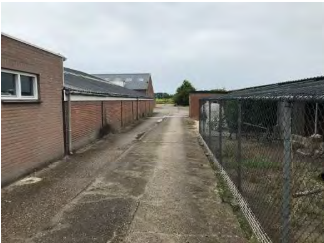
Foto 2: Erfpad (beton) tussen schuur en vogelren
