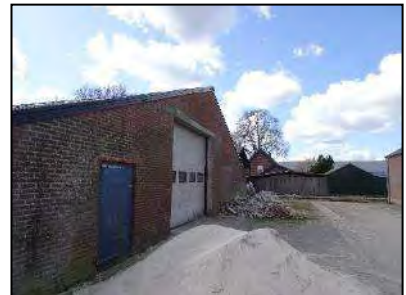
Figuur 8. Noordgevel voormalige koeienstal (stal gelegen in het verlengde van het woonhuis).
