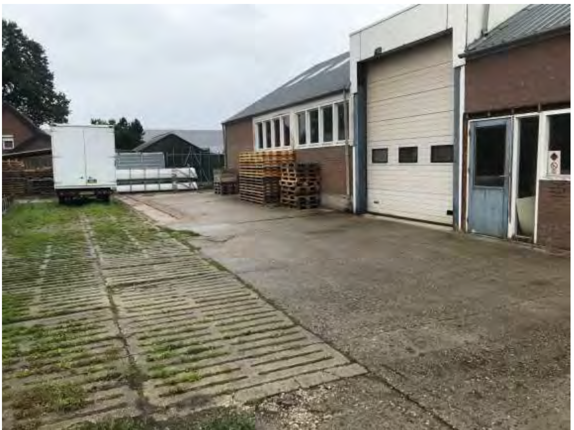
Afbeelding 2: Foto loods annex werkplaats met ligging betonverharding
