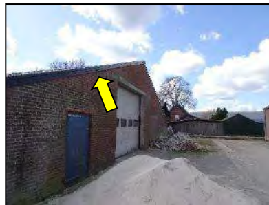
Figuur 18. Toegang voor vleermuizen naar ruimtes tussen in de spouwmuur via de daklijst aan de noordgevel van de voormalige koeienstal.
