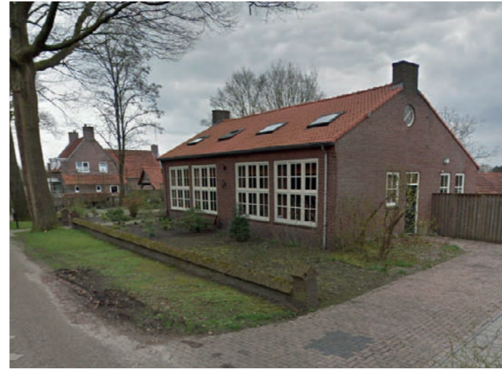
Voormalige school, Hendrik Jan Ypenberglaan 26
