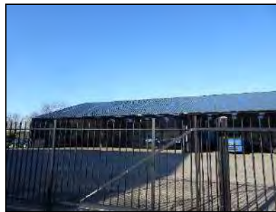
Figuur 4. Loods op westelijk deel van onderzoekslocatie.
