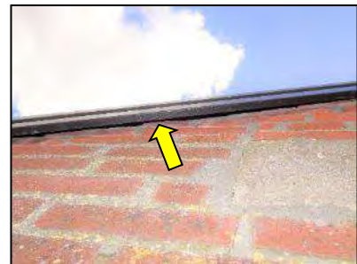
Figuur 19. Toegang voor vleermuizen naar ruimtes tussen in de spouwmuur via de daklijst aan de noordgevel van de voormalige koeienstal.
