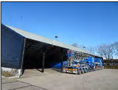
Figuur 6. Loods op westelijk deel van onderzoekslocatie.
