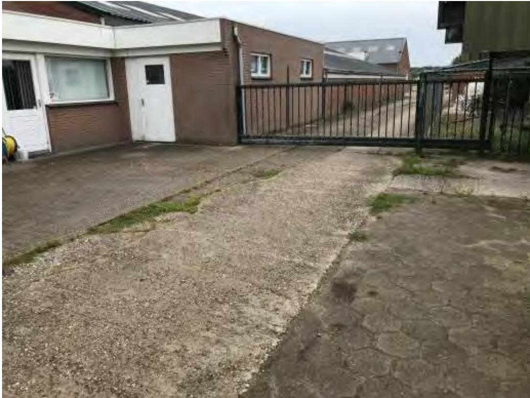
Foto 1: Toegangspoort met betonverharding en beton tegels
