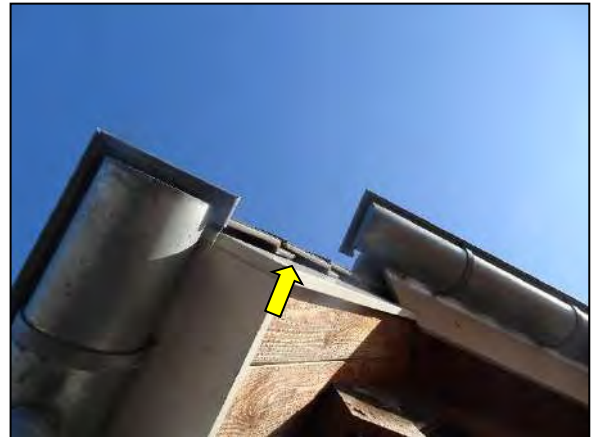
Figuur 19. Geschikte verblijfplaatsen voor vleermuizen; ruimtes onder overhangende dakpannen (bijgebouw nabij paardenstal).
