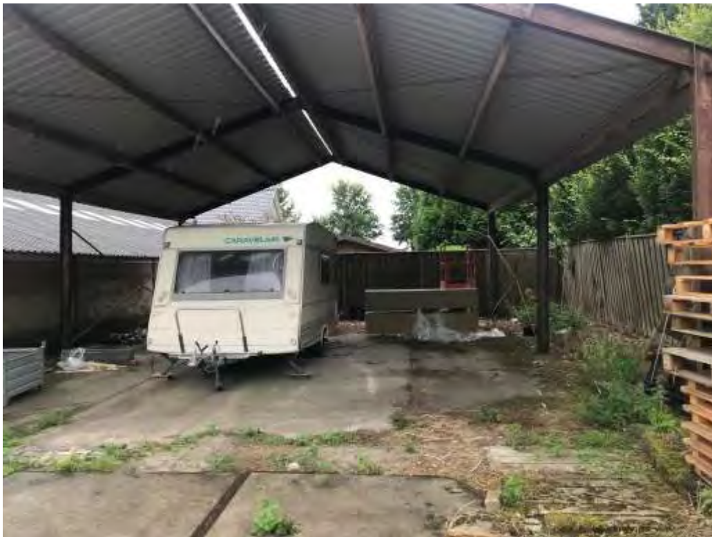
Foto 4: overdekte schuur met betonverharding
