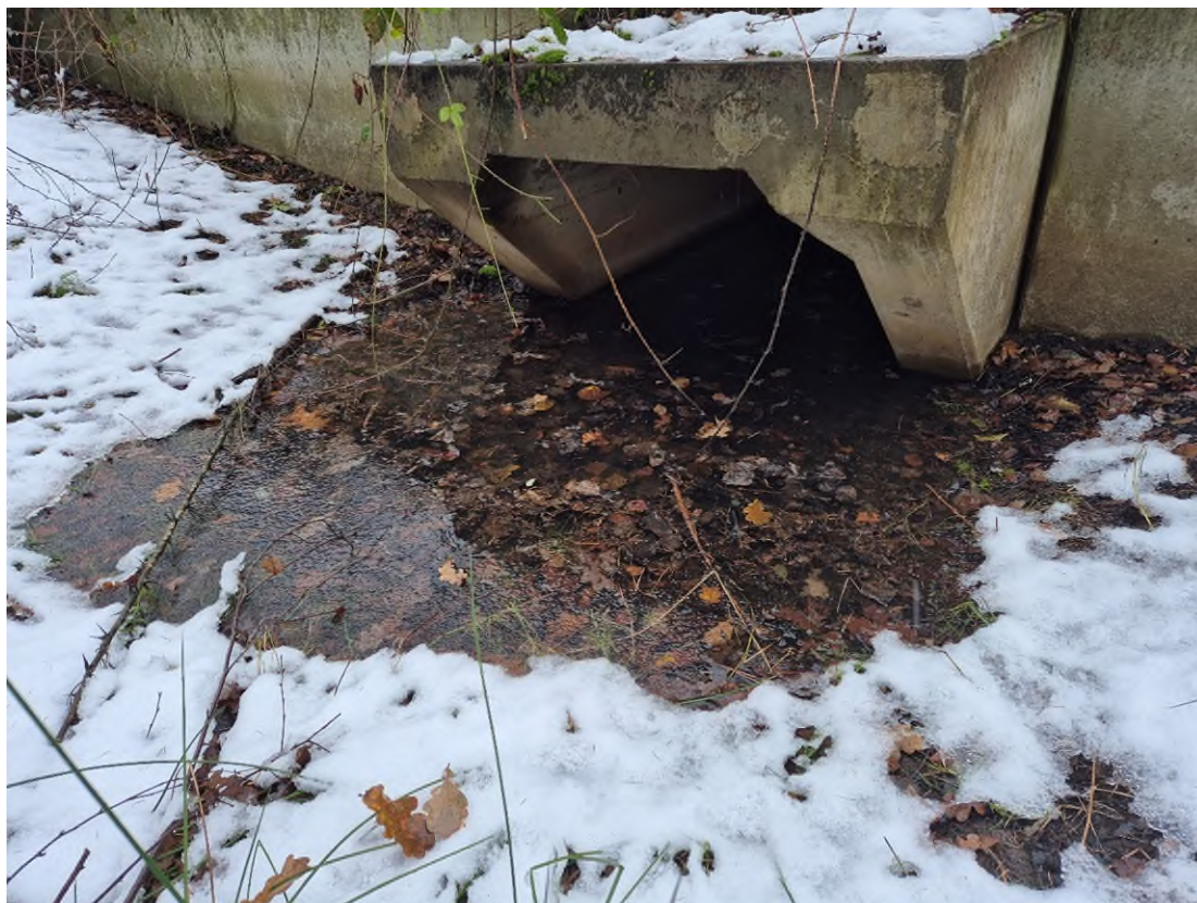
Figuur 3.4 Ondergelopen faunapassage
