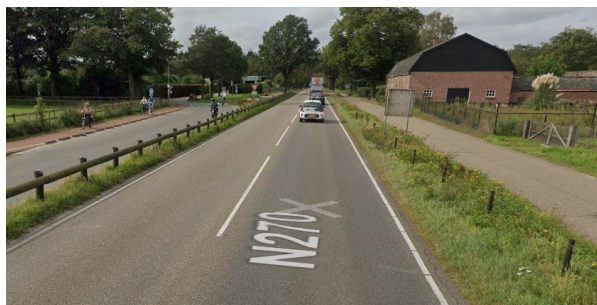
Figuur 37 Houten geleiderail in middenberm
