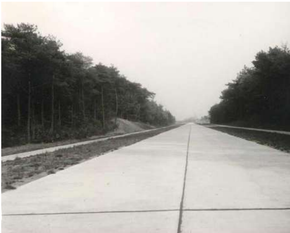
Figuur 20. Het wegdek van betonplaten met naast de weg de vrijliggende fietspaden, gezien richting Deurne. Aan de horizon is nog vaag de torenspits van de St. Willibrorduskerk herkenbaar (bron: www.deurnewiki.nl ).
