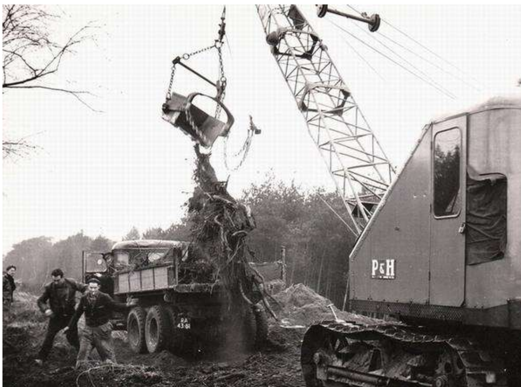
Figuur 18. Aanleg van de Helmondsingel / N270 (bron: Foka Deurne / www.deurnewiki.nl ).
