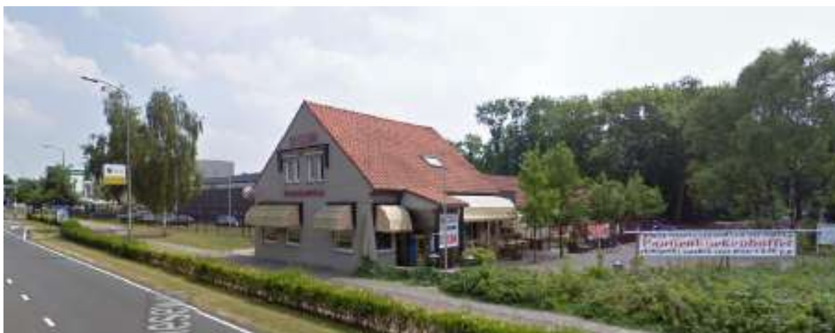
Figuur 43. Het huis 'In de Villa', juli 2009 (bron: Google Streetview).
