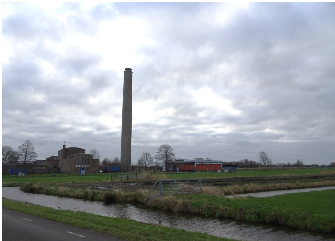
Afbeelding 3.16 Kenmerkend pompstation vanaf locatie Bergambacht West bekeken
