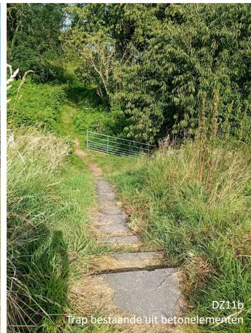
DZ11b Betonnen trap over tuimelkade
