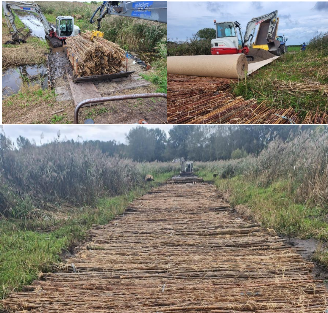
Figuur 9: Tijdelijke bouwweg van rijshoutmatten (wilgen), jute of cellulose scheidingsdoek en een afdekking van puingranulaat.
