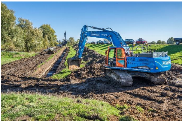
Figuur 18: Elektrisch aangedreven hydraulische graafmachine
