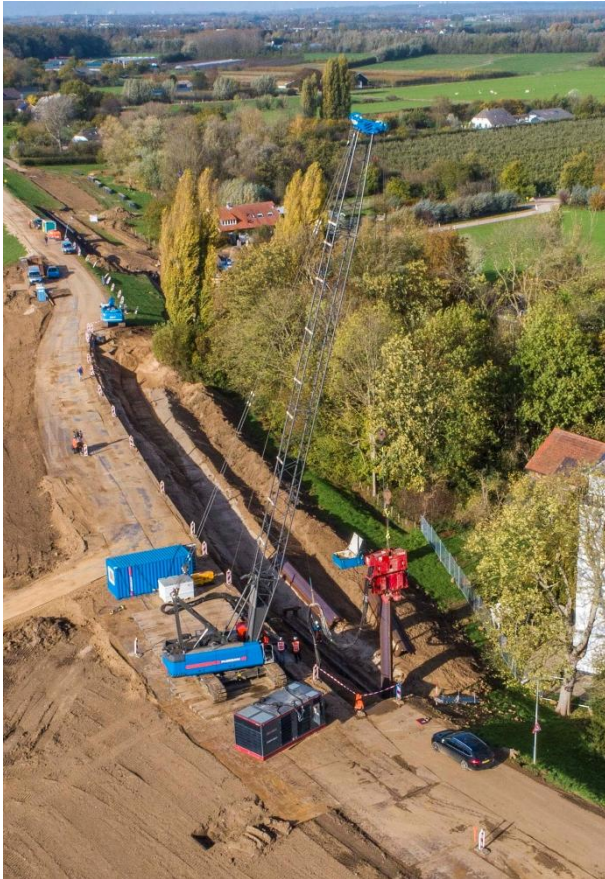
Figuur 23: Damwandstelling met trilblok
