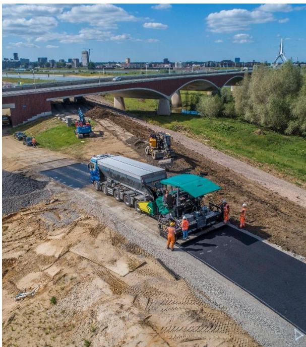
Figuur 27: Asfaltspreidmachine met vrachtwagen
