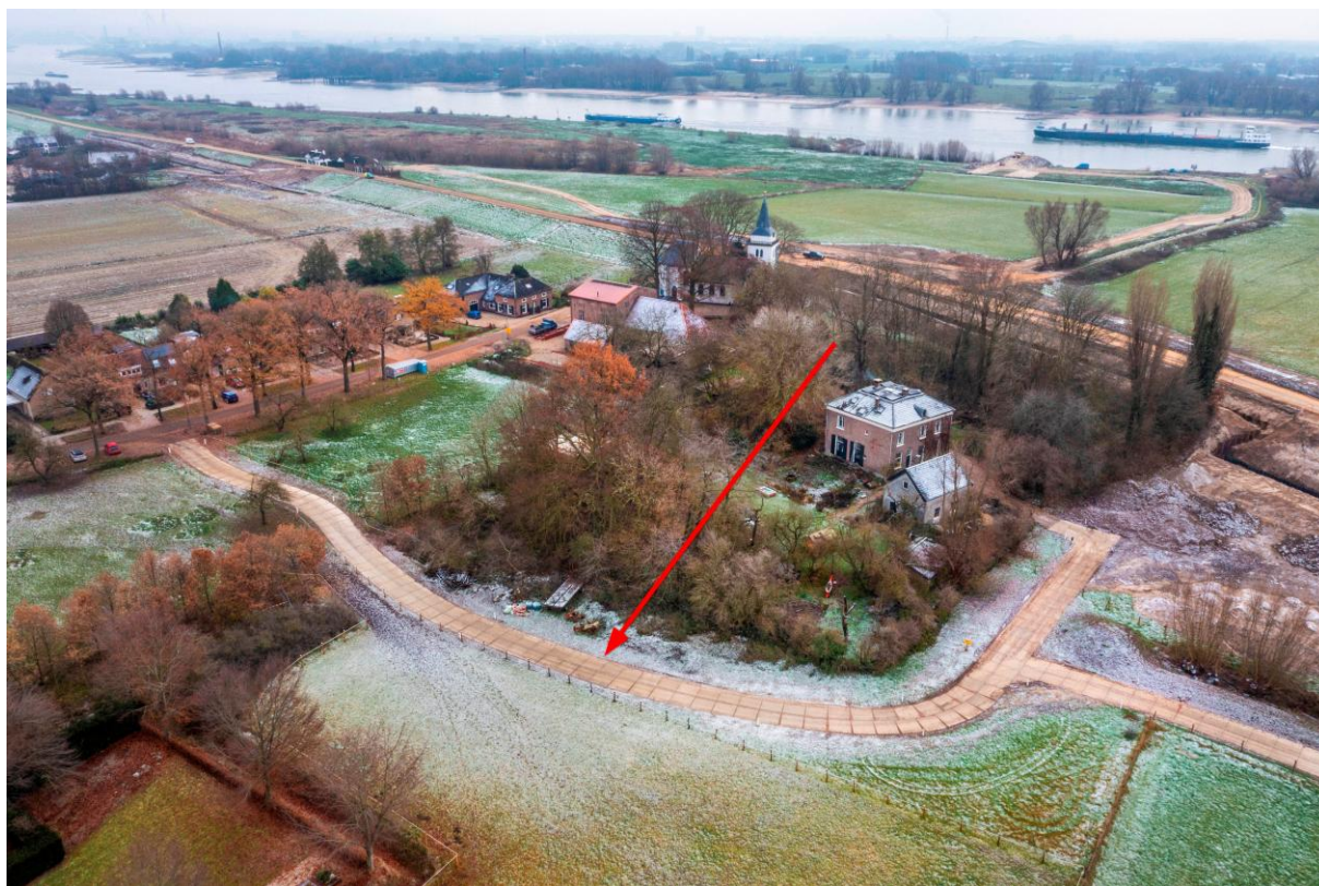
Figuur 41: Tijdelijke bereikbaarheid percelen met betonplaten
