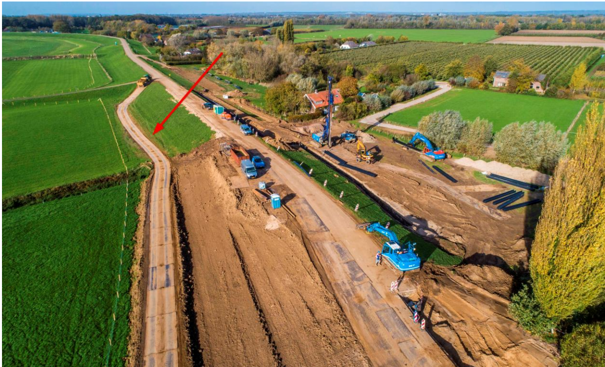
Figuur 40: Voorbeeld werkweg met stalen megaplaten
