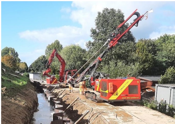
Figuur 7-1 Voorbeeld aanbrengen verankering bij damwanden
