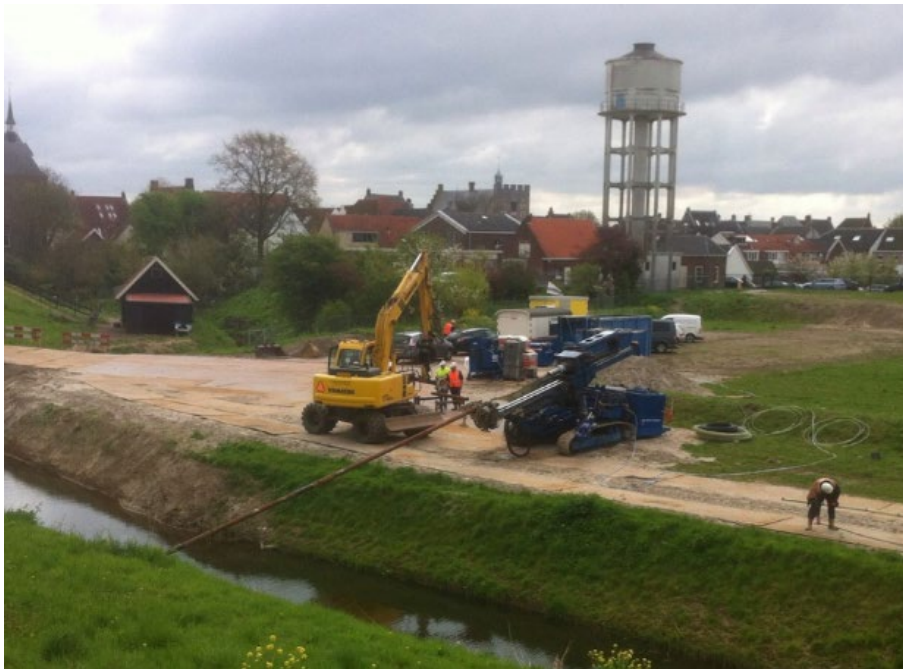
Figuur 7-1: Aanbrengen dijkvernageling in dijkvak 17 in 2016
