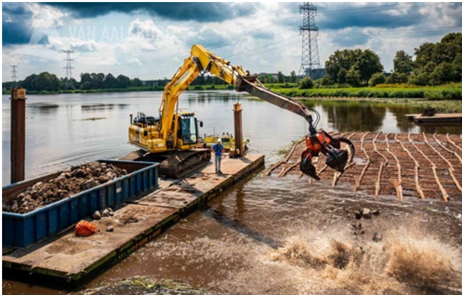
Figuur 7-2: Aanbrengen filerdoek met wiepen en stortsteen voor WS Aa en Maas 2024
