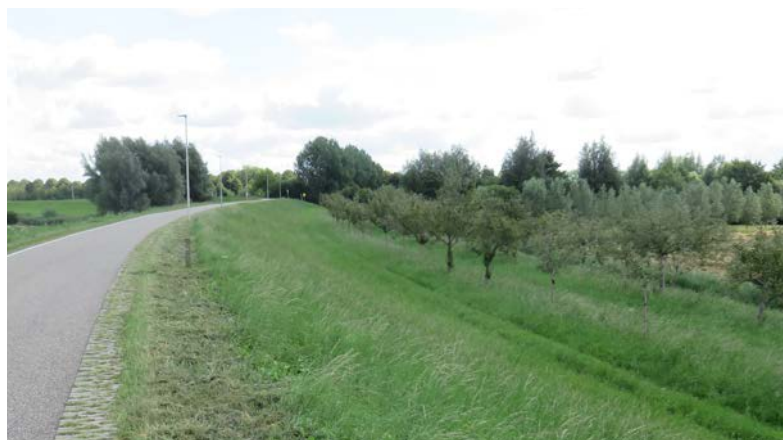
Overgangen dijkzone Vianen-west
