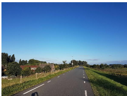
F1: Lekdijk nabij Fort Everdingen
