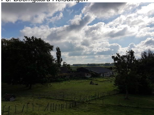
F5: Mogelijk asbestbevattend dak (Achthoven)
