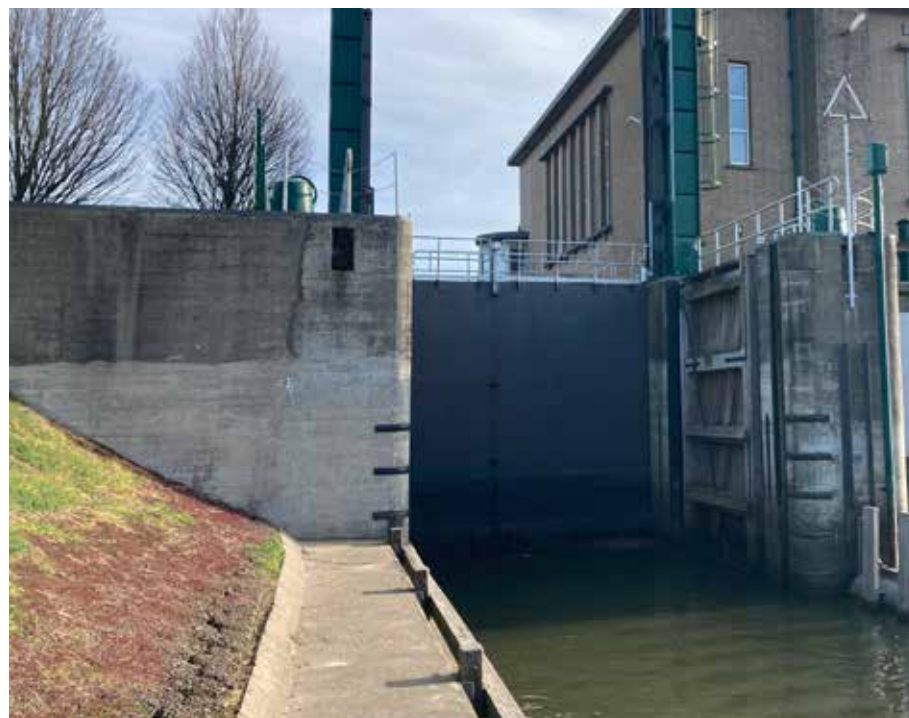
Het huidige gemaal met schutsluis voor recreatievaart
