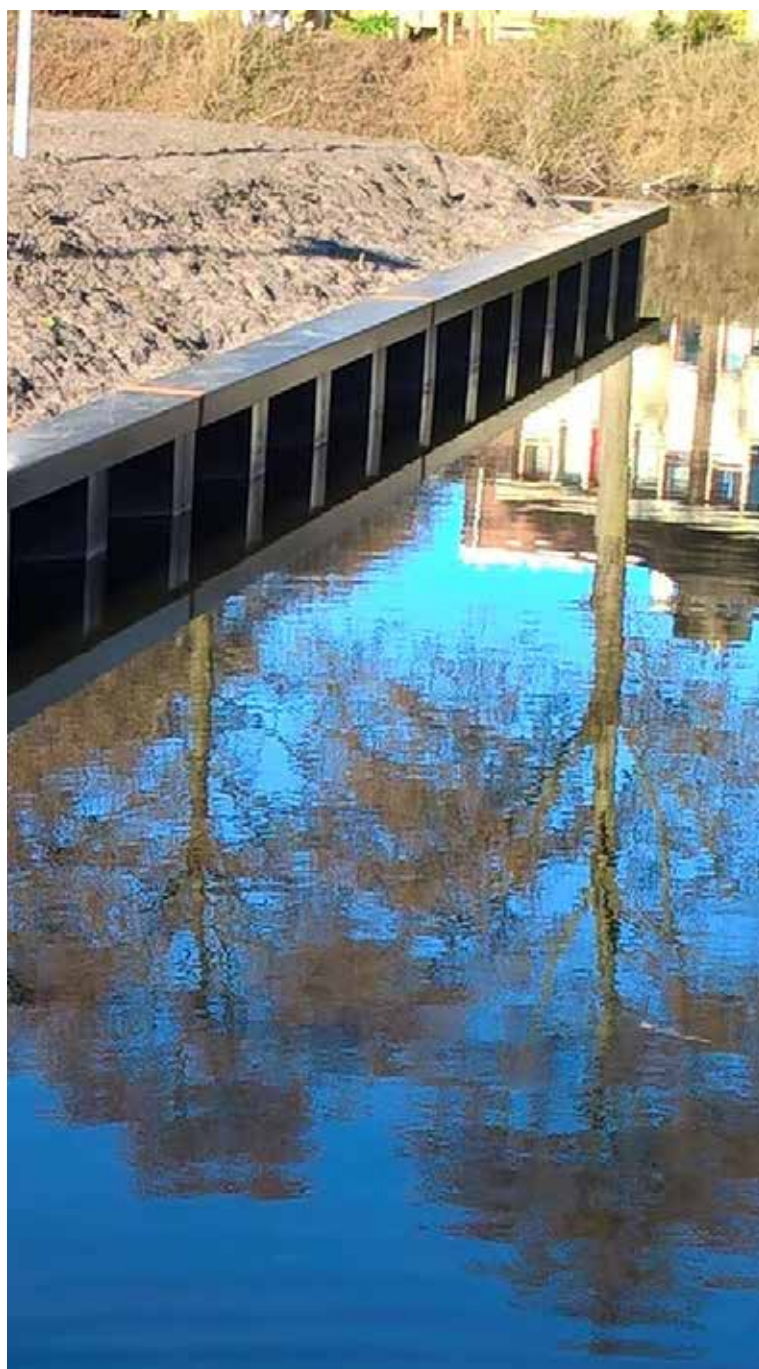
Stalen damwanden met deksloof als beschoeiing rondom spoor en Parallelweg ter plaatse van versmalling boezemkanaal
