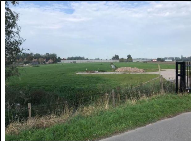
Deellocatie A: locatie Boezemgemaal aan de Kanaaldijk-Noord
