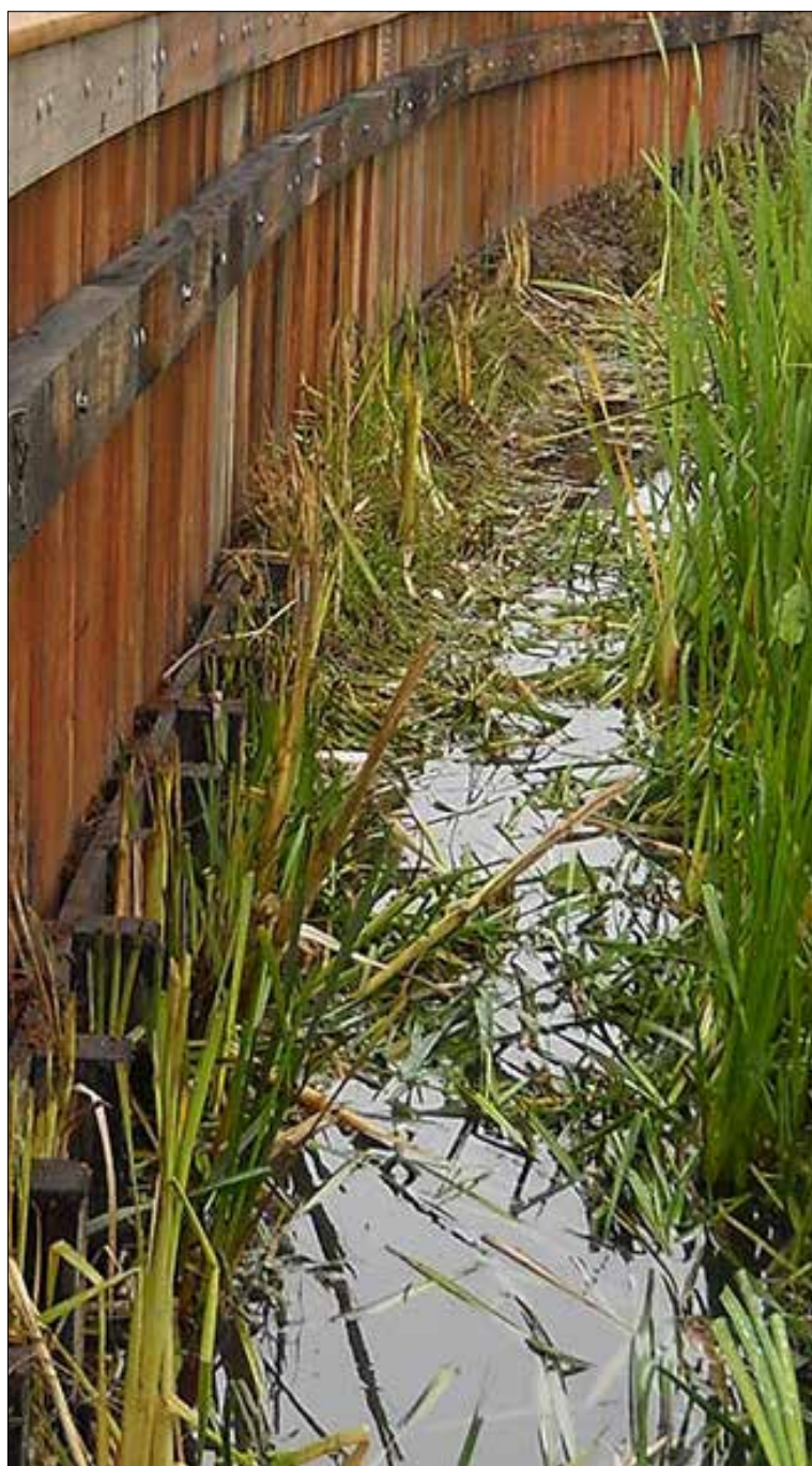
Damwand van hout als overgang tussen landhoofd kruising Pelgrimspad en natuuroever / plasberm en tussen Giessenlandjes en Wijde Giessen
