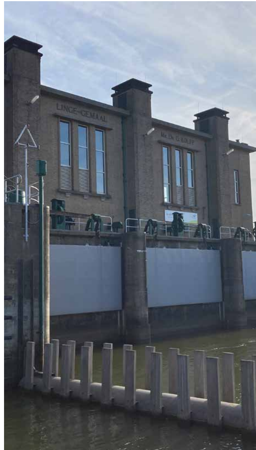
Het huidige gemaal met uitstroom richting Beneden Merwede
