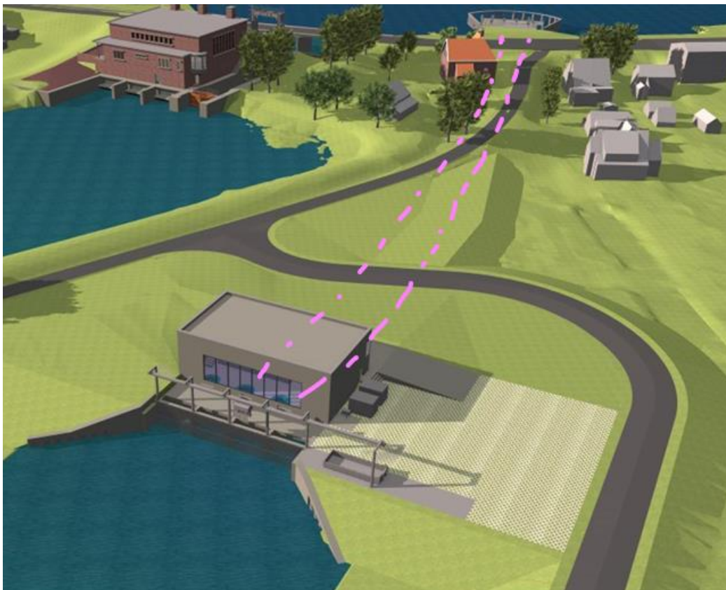
Figuur 15: visuele impressie nieuwe gemaal, gezien van noord naar zuid. In paars schematisch de ligging van de ondergrondse perskokers.
