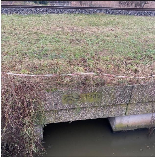
Figuur 4-2 Betonnen duiker onder het spoor
