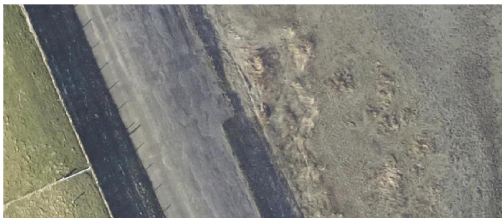
Afbeelding 3.7 Luchtfoto tussen DP6.9 en DP7.0
