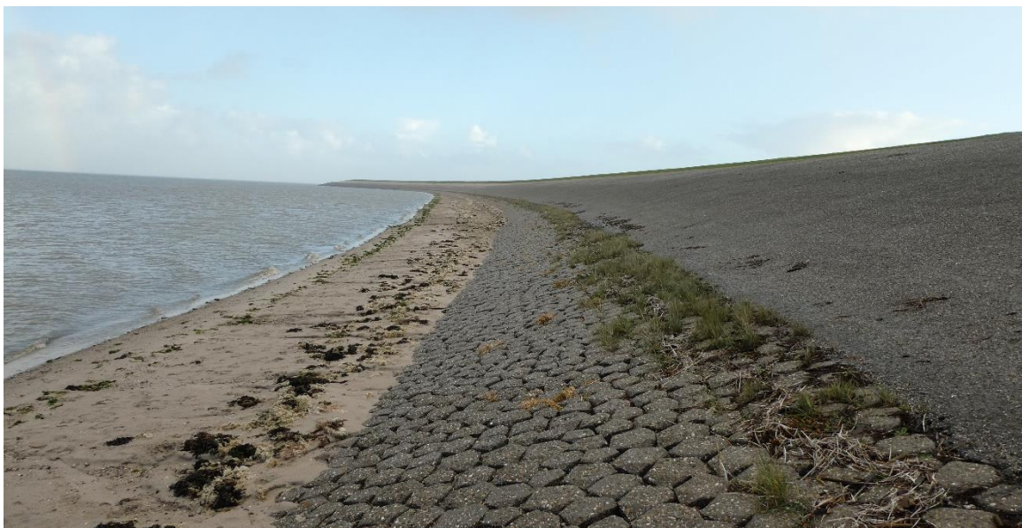
Afbeelding 2.8 Wieringer Zeewering ter hoogte van Hippolytushoef. De zetsteenbekleding is hier aangezand, hiervan is slechts op een deel van de sectie sprake
