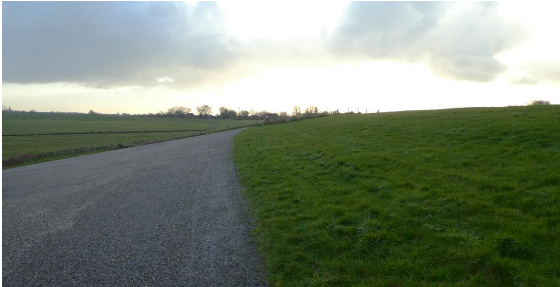
Afbeelding 2.11 Polder Stroe west
