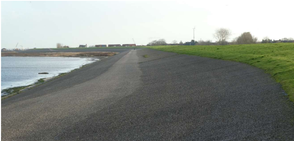
Afbeelding 2.14 Wieringerzeewering ten oosten van Vatropp
