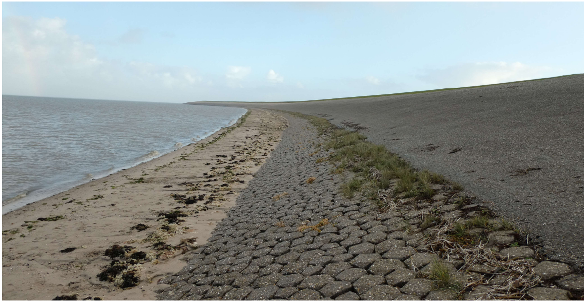
Afbeelding 2.9 Wieringer Zeewering ter hoogte van Hippolytushoef. De zetsteenbekleding is hier aangezand, hiervan is slechts op een deel van de sectie sprake
