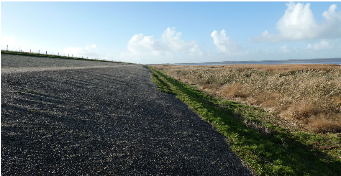
Afbeelding 2.7 Amsteldiepdijk buitendijks, zetsteenbekleding aan de onderrand is nauwelijks zichtbaar, want overgroeid met gras
