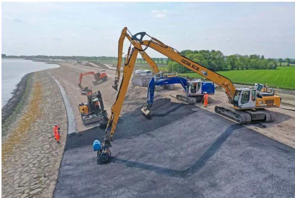
Afbeelding 1.19 Voorbeeld aanbrengen waterbouwasfalt met hydraulische graafmachine (bron: Aveco de Bondt)
