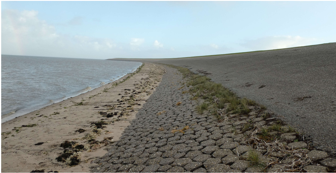
Afbeelding 1.8 Wieringer Zeewering ter hoogte van Hippolytushoef. De zetsteenbekleding is hier aangezand, hiervan is slechts op een deel van de sectie sprake
