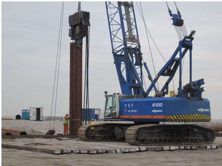
Afbeelding 1.11 Voorbeeld van aanbrengen damwand met draadkraan (bron: Volker Staal en Funderingen)
