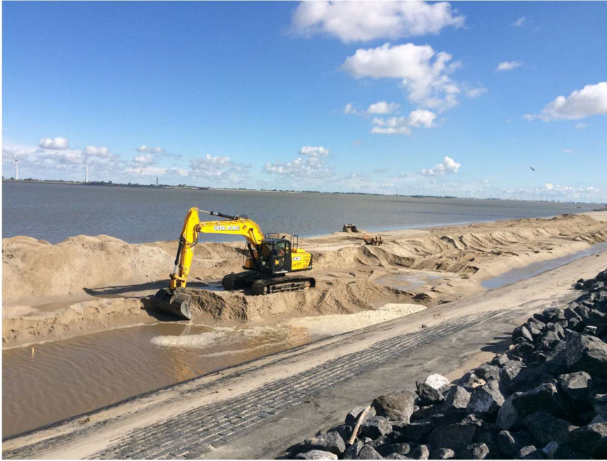
Afbeelding 1.16 Graafmachine t.b.v. ontgraven aanzanding (bron: Witteveen+Bos)
