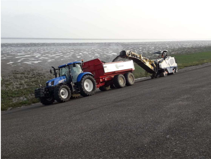
Afbeelding 1.14 Asfaltfrees en dumper t.b.v. verwijderen asfalt (bron: Freesmij)
