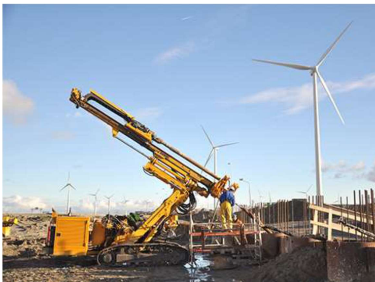
Afbeelding 1.12 Voorbeeld van aanbrengen groutankers met ankerboormachine (bron: Bauer Funderingstechniek)
