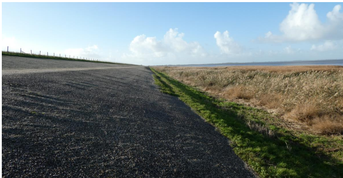
Afbeelding 2.6 Amsteldiepdijk buitendijks, zetsteenbekleding aan de onderrand is nauwelijks zichtbaar, want overgroeid met gras
