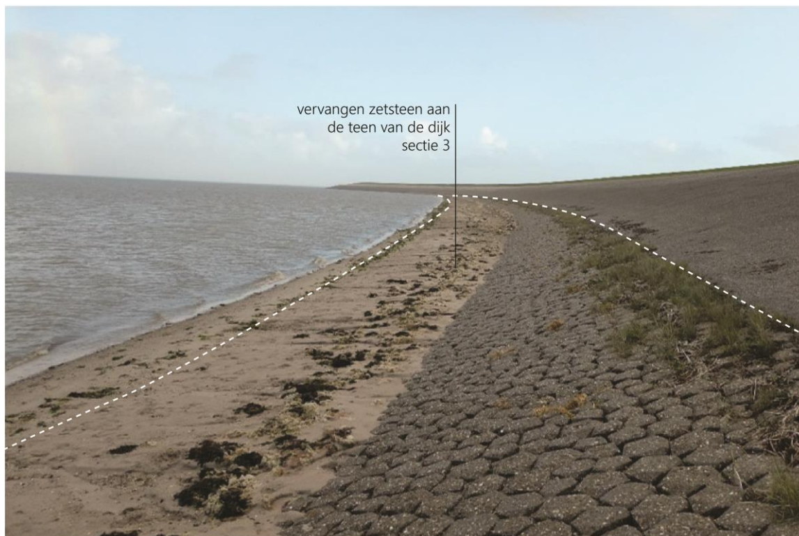
Afbeelding 2.9 Ontwerp sectie 3 (foto 1 op overzichtskaart in afbeelding 2.1)
