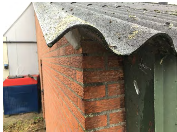
Figuur 13: Ontbreken van dakgoot
