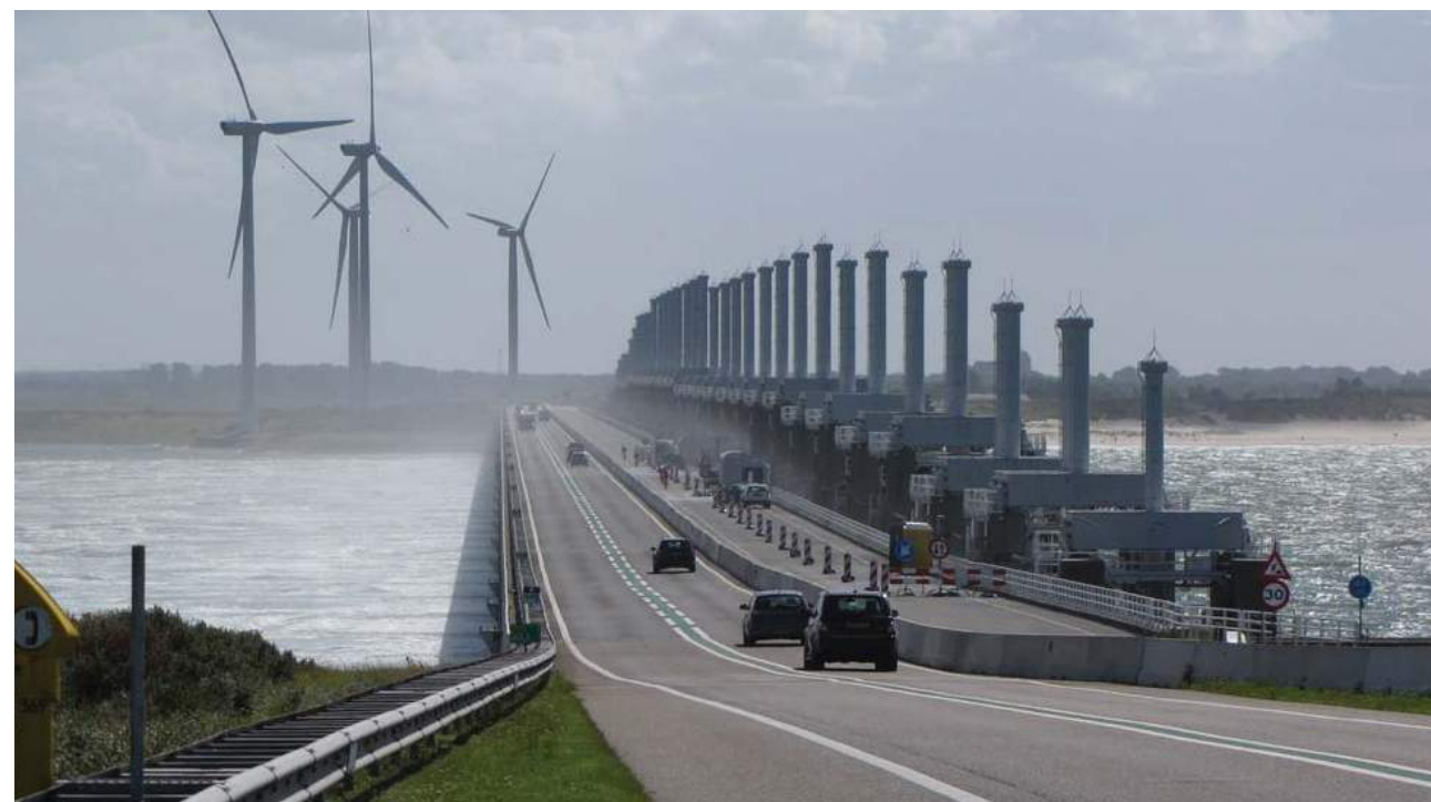
Oosterscheldekering gezien vanaf de noordzijde op Roggenplaat
