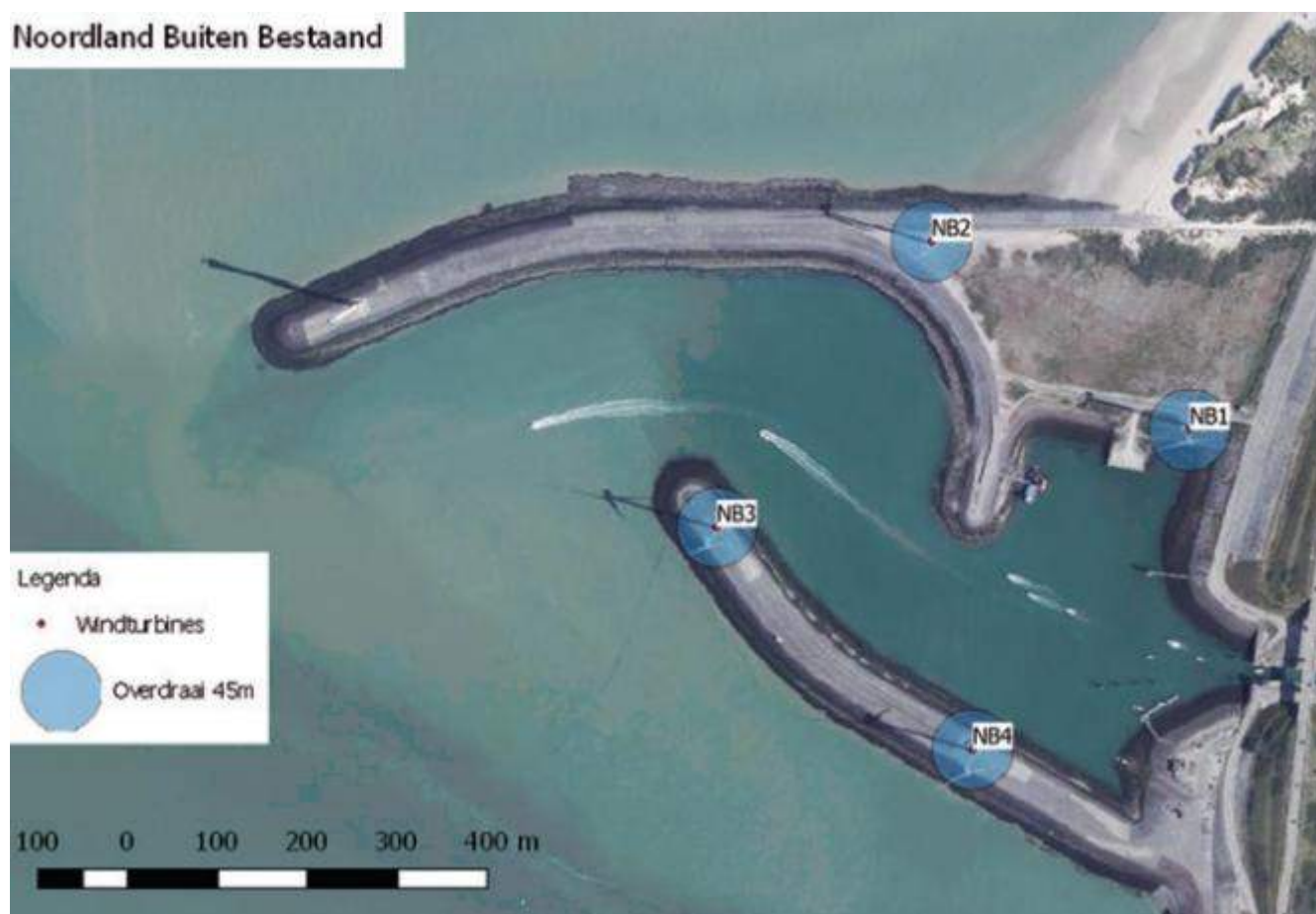
Figuur 2.3 Bestaand Windpark Noordland Buitenhaven (Windpark Roompotsluis)
