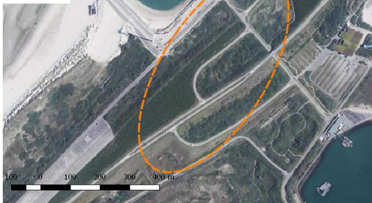
Figuur 3.4 Globale begrenzing zoekgebied op en rondom het Viaduct Poolvoet
