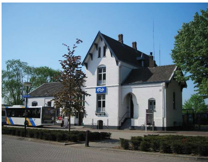
Figuur 16: Rijksmonument stationsgebouw Boxmeer
