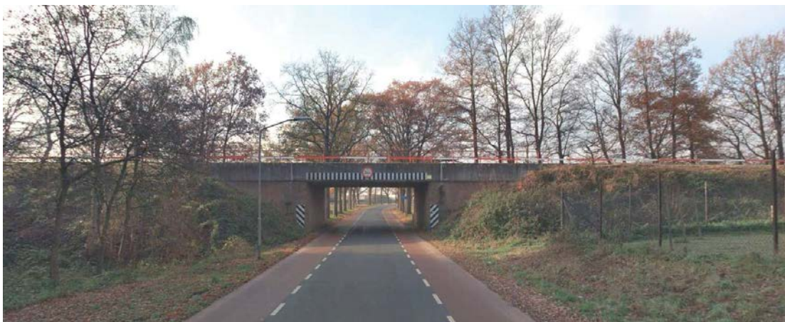
Figuur 50: Spoorviaduct over Raaieind in Grubbenvorst
