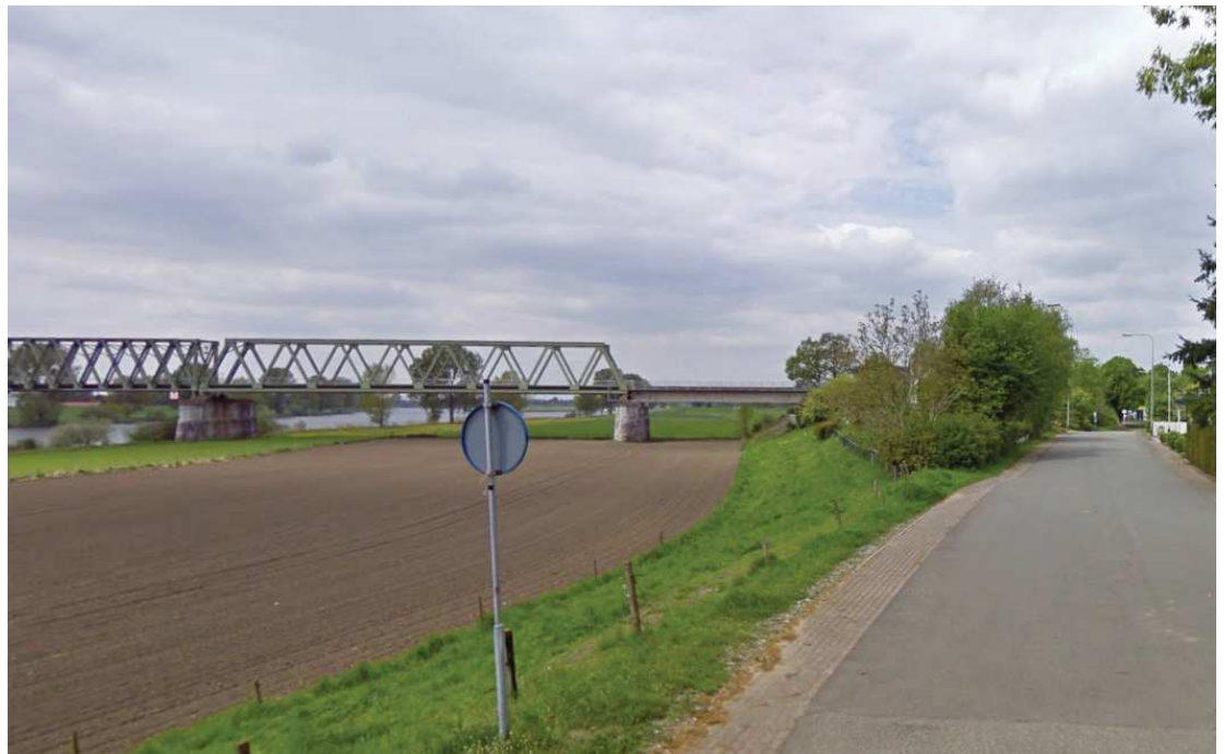
Figuur 35: Zuidelijke aanlanding van de vakwerk spoorbrug over de Maas bij Mook met karakteristieke pijlers
