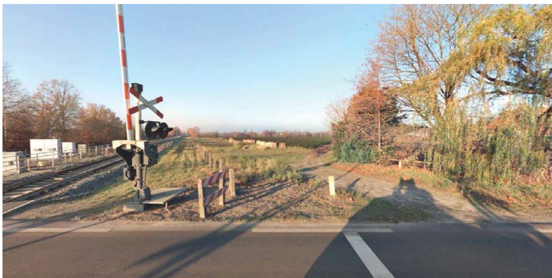
Figuur 49: Huidige situatie van de beoogde locatie voor onderstation Melderslo
