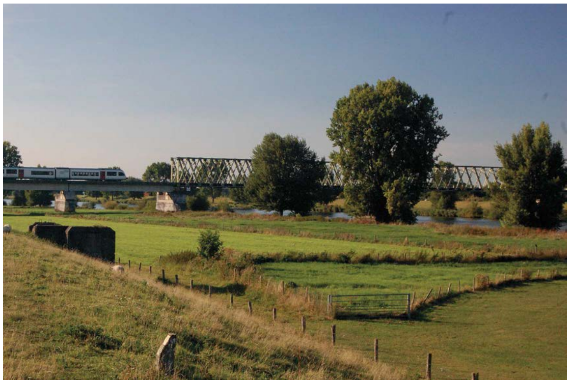
Figuur 8: De spoorbrug over de Maas nabij Mook
