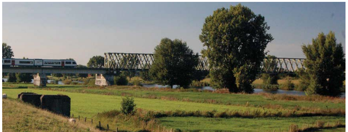
Figuur 36: Zuidelijke aanlanding van de spoorbrug over de Maas ten noorden van Cuijk met de karakteristieke pijlers
