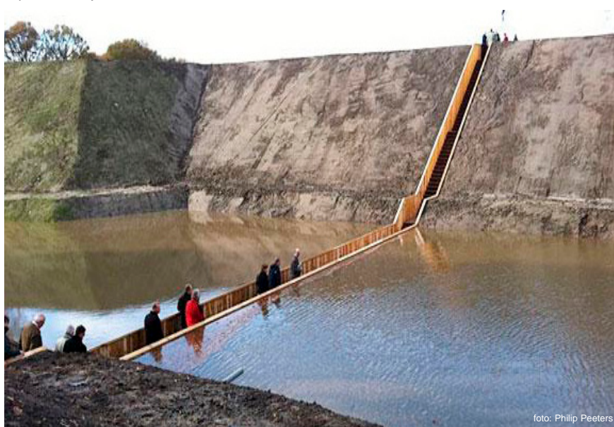
De Mozes Brug bij fort Roovere geeft een idee hoe een weg door het gebied kan lopen. Het water is de overlaat en de brug is de weg. Een unieke belevenis.
