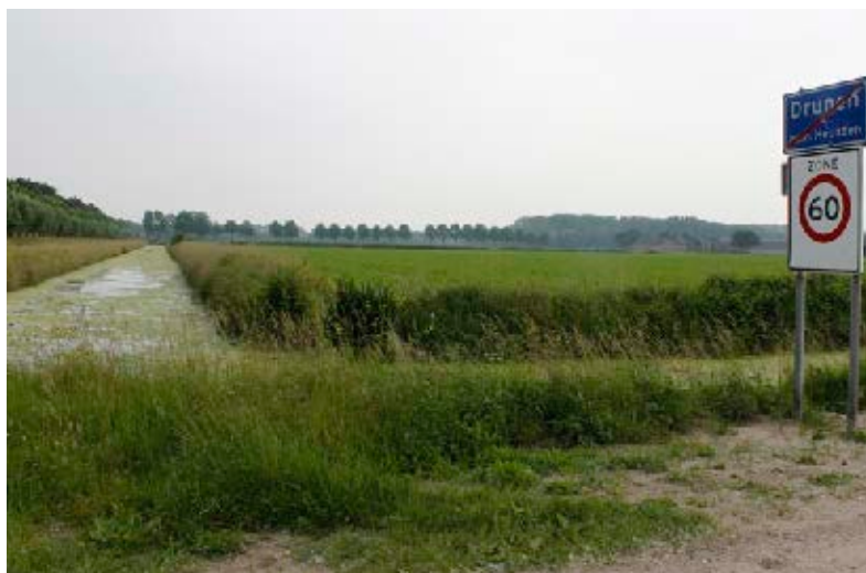
Huidige situatie tussen Dwarsweg en Overlaatweg
