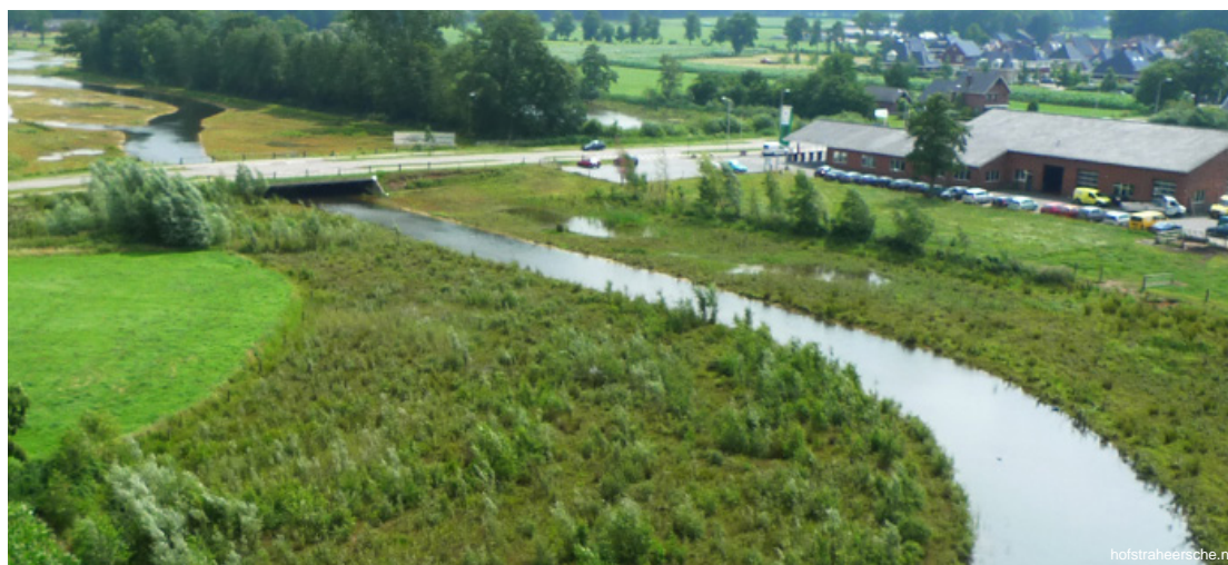
De ecopassage bestaat uit een natte en droge verbinding
