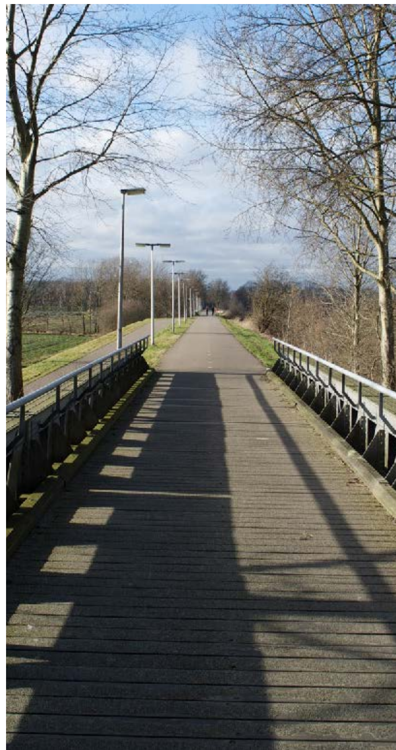
Spoordijk met spoorbrug
