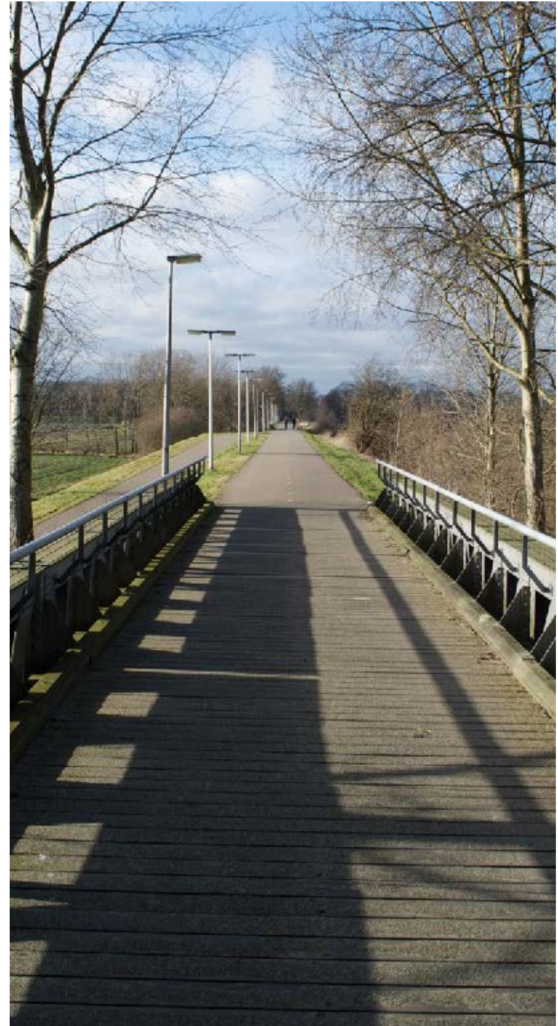
Spoordijk met spoorbrug
