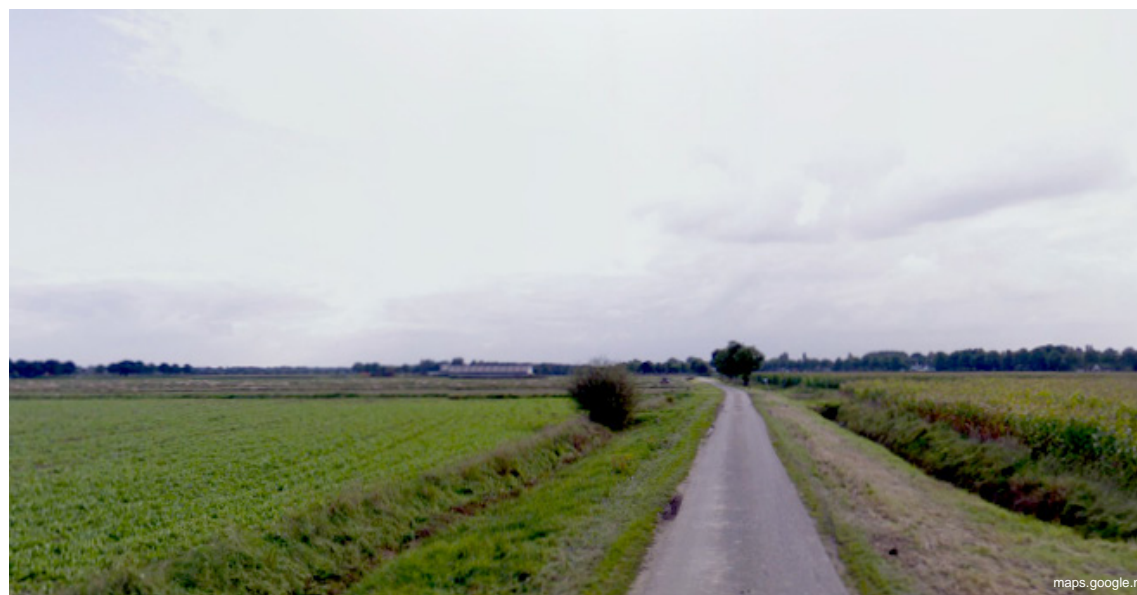
Eenvoudige weg door de open polder (huidige situatie Voorste Zeedijk, Polder van Bokhoven)
