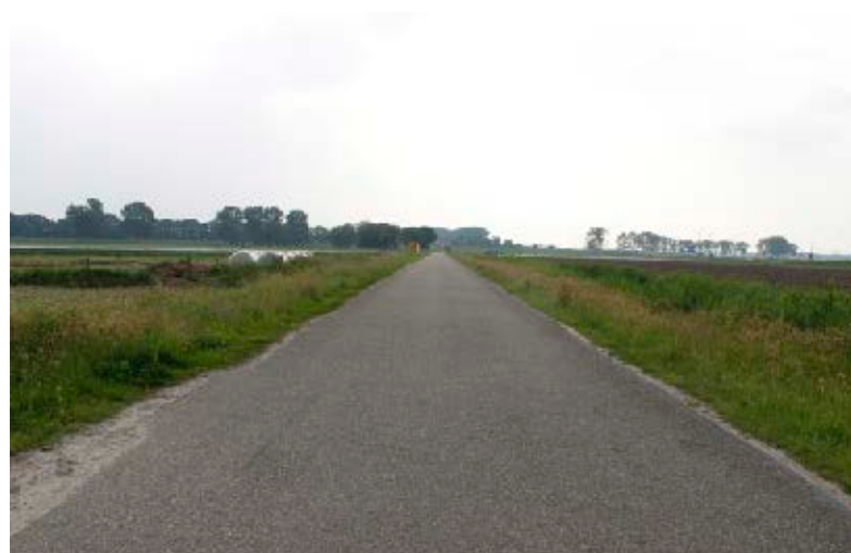
Baardwijkse Overlaat tussen de Spoordijk en A59. Overstortweg richting Waalwijk
