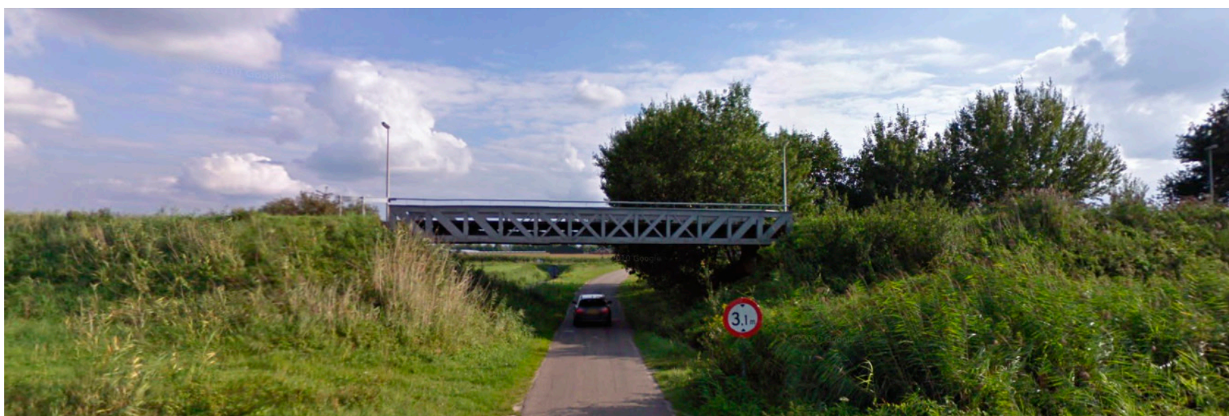
Bestaande onderdoorgang spoordijk gezien vanaf de noordzijde, nieuwe weg ligt aan de linkerzijde.
