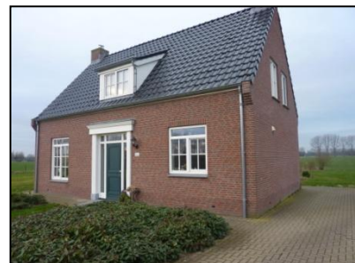
Figuur 18. Woonhuis heeft geen open stoorvoegen die toegang bieden tot een spouwmuur.
