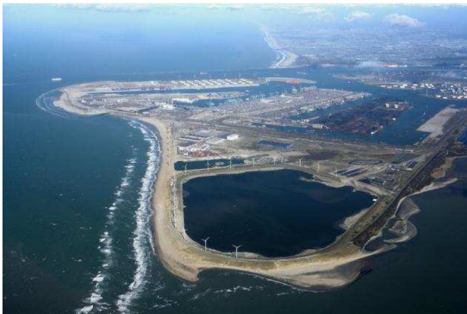
Afbeelding 1.1. De Slufter met de huidige opgestelde turbines
