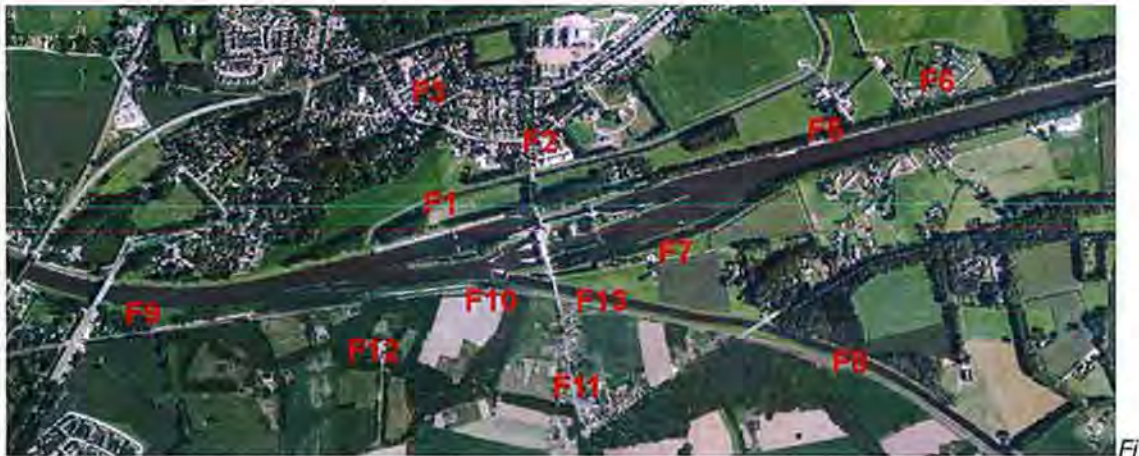
figuur 2.2 Overzicht omgeving sluiscomplex
