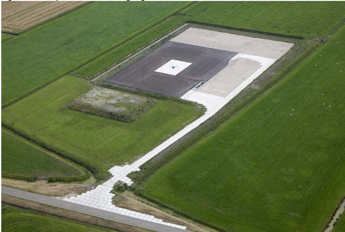
Figuur 1 Impressie van een aangelegde boorlocatie
