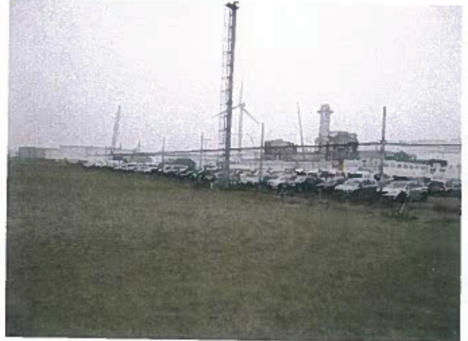
Foto 10: Electriciteitscentrale in aanbouw
