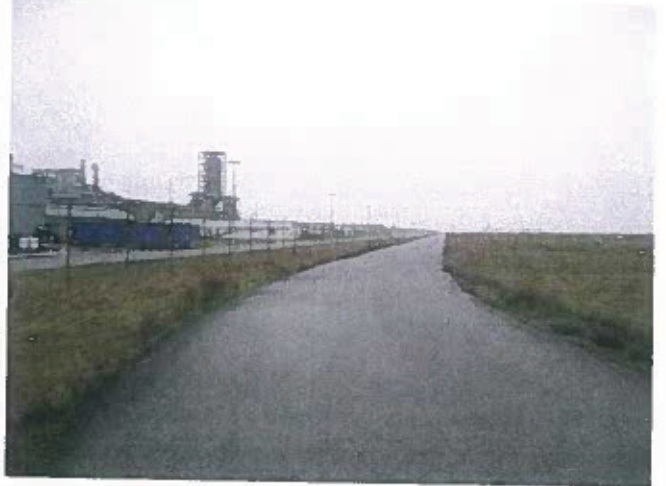
Foto 28: asfaltweg locatie A
