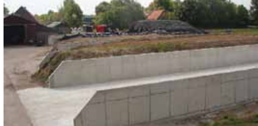
Sleufsilo's op het achtererf
