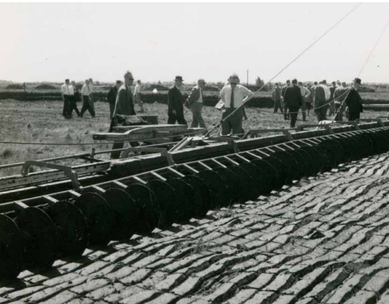
oude energie | turfwinning in de Veenkoloniën (Amsterdamse veld) door een persturfmachine © Afdeling Multimedia Rijkswaterstaat
