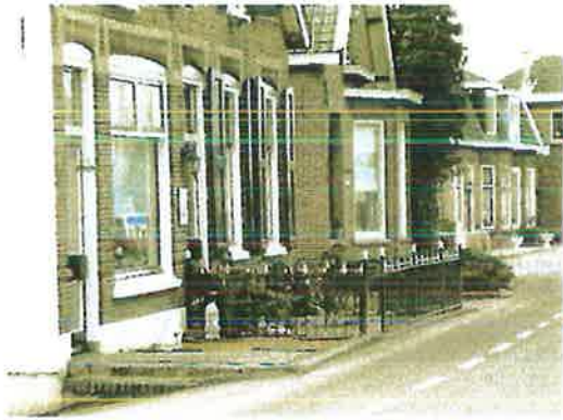
Bebouwing dicht op de dijk
