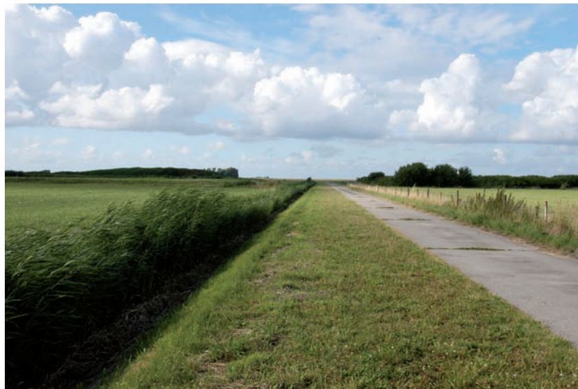
Opstreckende weg naar de achterliggende kavels
