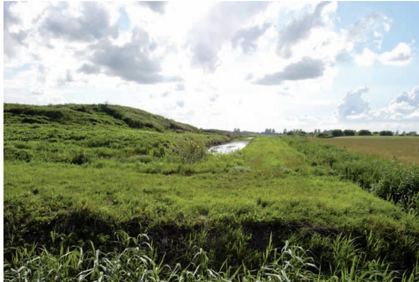
Gronddepot met ringsloot naast vloeiveld, geheel begrensd door kavelsloot
