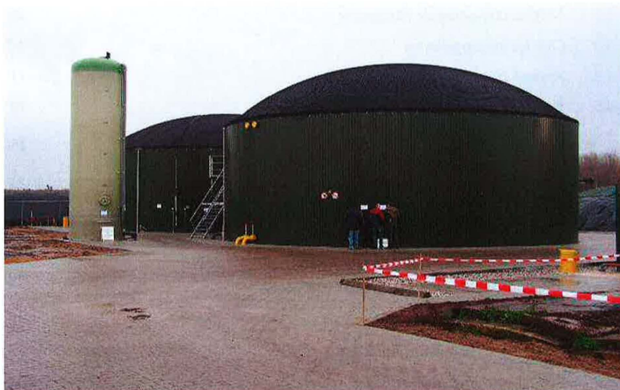
Figuur 1. Vergisters en breivoersilo (Ekwadraat).
