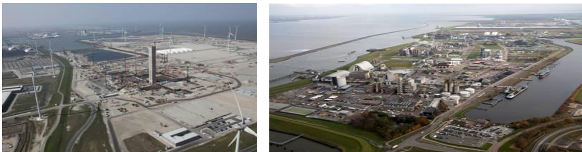
Figuur 1.1 Energiepark Eemshaven en chemiecluster Delfzijl
