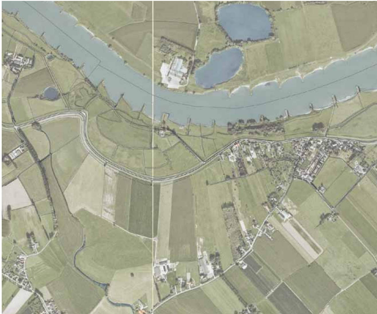
luchtfoto i.c.m. GBKN
