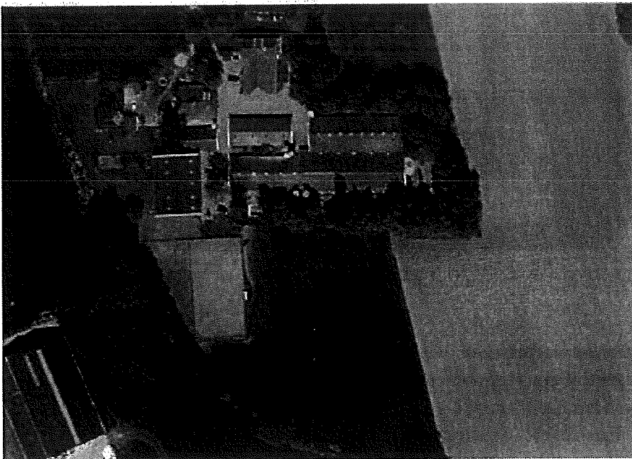
Luchtfoto huidige situatie
