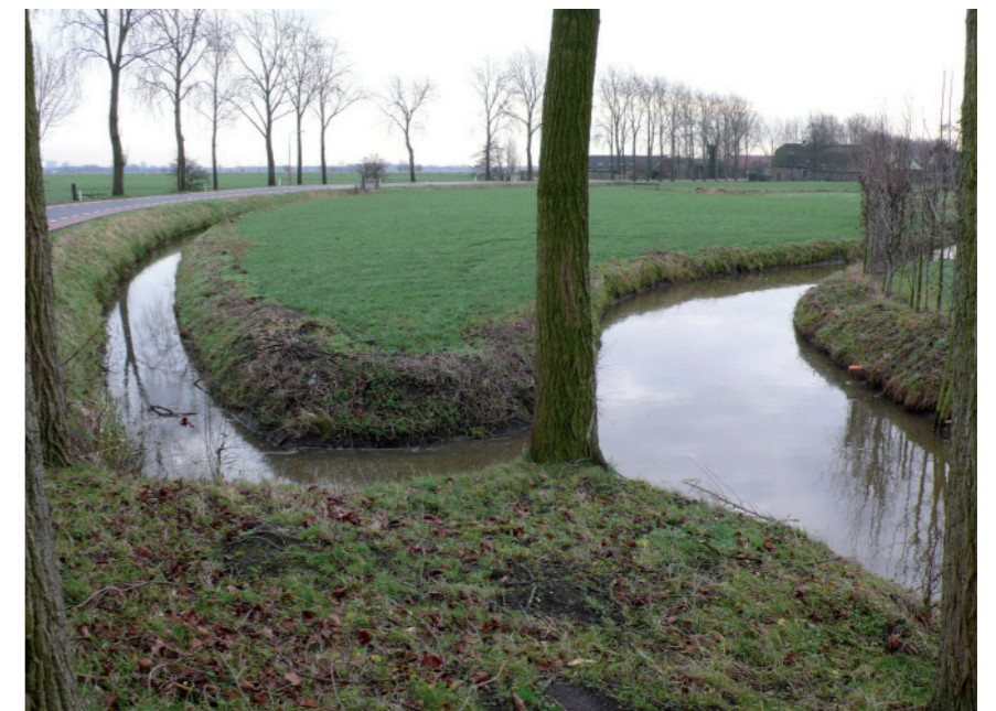
kruising van IJsselwetering en de Nedereindse Weg
