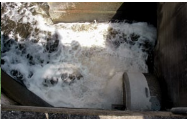
Gemaal Leeghwater. Hier wordt vanuit het boezemsysteem water ingelaten in de Haarlemmermeer. Het gaat jaarlijks om 20 tot 40 miljoen m 3 boezemwater
